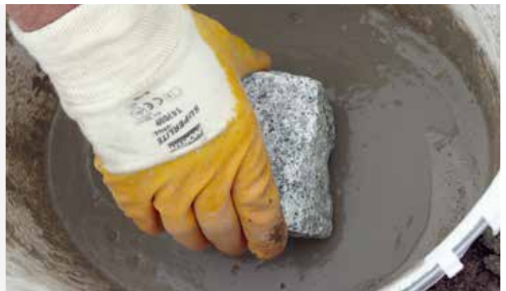
tubag TNH-rapid hechtspecie wordt direct voor het leggen op de onderkant van de steen of tegel aangebracht. Bij bepaalde constructies kan de hechtspecie op de legmortel gespoten worden.
