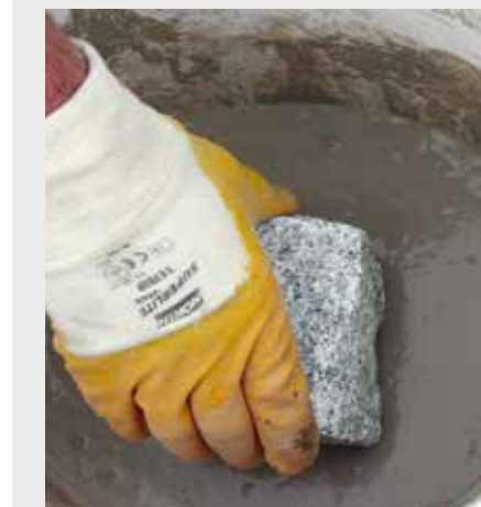
Bestratingselement in hechtspecie dompelen. Alternatief aan de onderkant insmeren.
