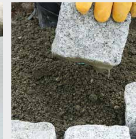
Bestratingselement met een hamer vast in de verse bedmortel (bv. tubag TPM-D4) kloppen.
