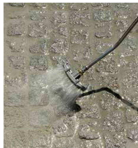
Bestratingsvoegmortel van het oppervlak spuiten.
