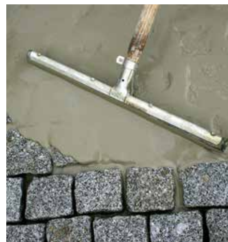
De sterk vloeibare en zelfverdichtende voegmortel aanbrengen.
